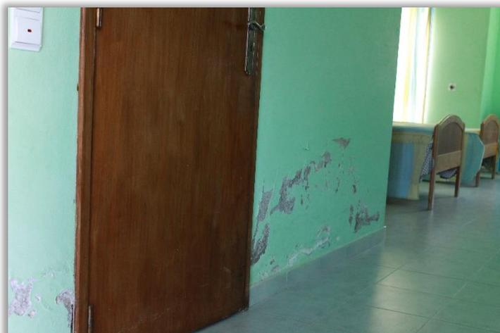
Pintar ou colocar revestimento tipo placa para proteger do desgaste das cadeiras de rodas
